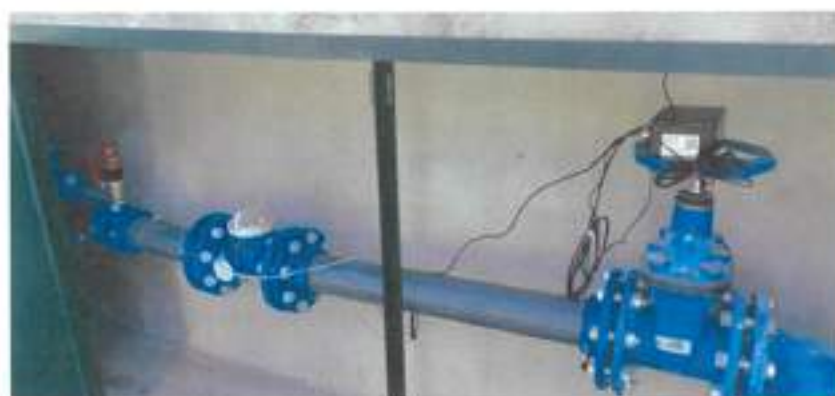
Figura 1 – Exemplo de Zona de Monitorização e Controlo.
